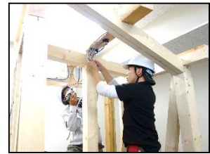
図6 電気配線工事
