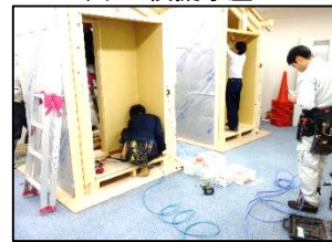
図7 外断熱及び内装
