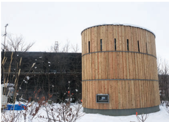
写真右上／トヨエモンの間伐材「耳付きの木」。木の外周が残っている。 写真右下／この現場の棟梁、高松裕嗣さん(写真左)は現在26歳。入社4年目から棟梁を務める若手のエースだ。 写真左上・左下／建設中だったのは、耳付きの木を外壁にぐるりと貼った、楕円型の書庫。耳の部分がデザインのポイントになり、おしゃれ。「能書きだけではお客様には選んで頂けない。デザインや機能性で納得して頂けるものを造らないと」と、武部さん。
