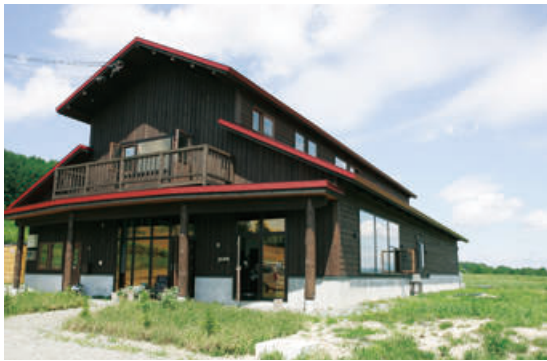
写真上／2006年に完成した岩見沢市内の宝水ワ イナリー。古い木造倉庫を移築し、販売店兼醸 造工場に。軒下には丸太をそのまま使った柱が。 写真中／築110年の古民家を2014年に移築再生。 厚真町の旧畑島邸。現在はパン屋「此方(こち)」 として営業している。 写真下／2019年に完成したばかりの、納骨堂。 外壁面にトヨエモンの間伐材が使われている。 板の外側の線が少し揺らいでいるのがわかる。
