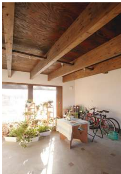
写真左/南側の窓から土間に差し込む太陽光がコンクリートに蓄熱され、家を温めます。新しく作った土間の天井には新材を使用。写真右/2階は構造材が見渡せる開放的な造りになっています。寝室は別一室。
