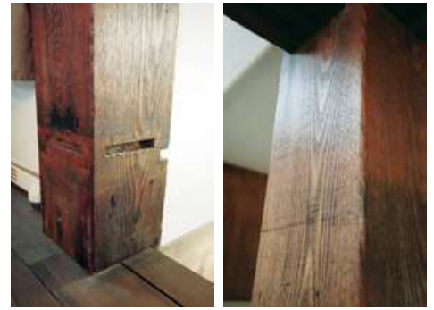
写真左/床は元の位置よりも低くし空間を広くする工夫が施してあるそうです。ホゾ穴のところが以前の床位置。写真右/前の家主の子どもたちによるものでしょうか。身長を測った跡が残ります。
