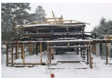
解体作業は冬の間に大工4~5人で行なわれました。バラした材は一度持ち帰り、磨いてから再度組み立てられます。(写真提供/武部建設)
