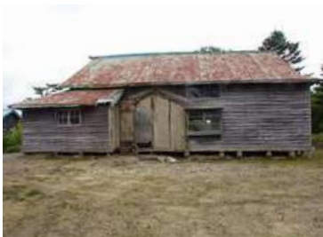
なんと、この家が左ページ上の写真のようになりました！ 岩見沢の農家のものだったこの家は移築時にちょうど築100年を迎えたそうです。(写真提供/武部建設)
