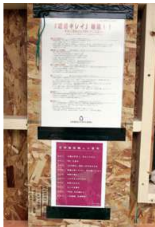
写真上／建設中のこの家でも居間の見えるところに古材が数本使用されていました(写真では紙に包まれています)。古材はこの敷地に以前建っていた納屋のもの。 写真下／建設現場がとてもきれいに整頓されていることにびっくり。現場には「現場キレイ推進」と「職人十箇条」の張り紙が。
