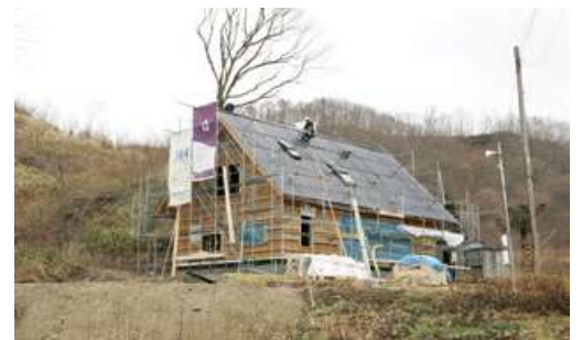
2010年12月に建設中だったむかわ町の現場。実家の敷地内に新居を建てるといってお施主さんですが、かなり住まいにこだわる方であちこちの工務店を訪ね歩き、最後に辿り着いたのが武部建設だったそうです。
