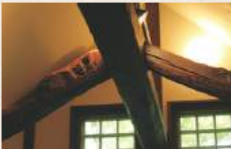
三笠本社敷地内にある民家再生モデルハウスでは、高い断熱性と気密性を実感できる。
