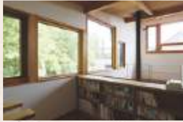
太陽の南中高度を計算に入れて窓を設置。夏は涼しく、冬は暖かい。
